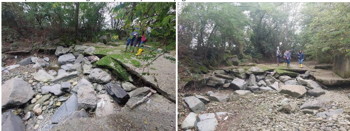
Figura 8 – Soglia fissa funzionale a una derivazione irrigua ormai in disuso e alla stabilizzazione del fondo alveo. Condizioni di dissesto
