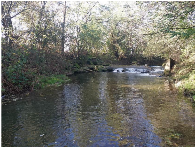
Foto 5 – Soglia funzionale alla derivazione in destra e alla stabilizzazione del fondo alveo. Vista da valle
