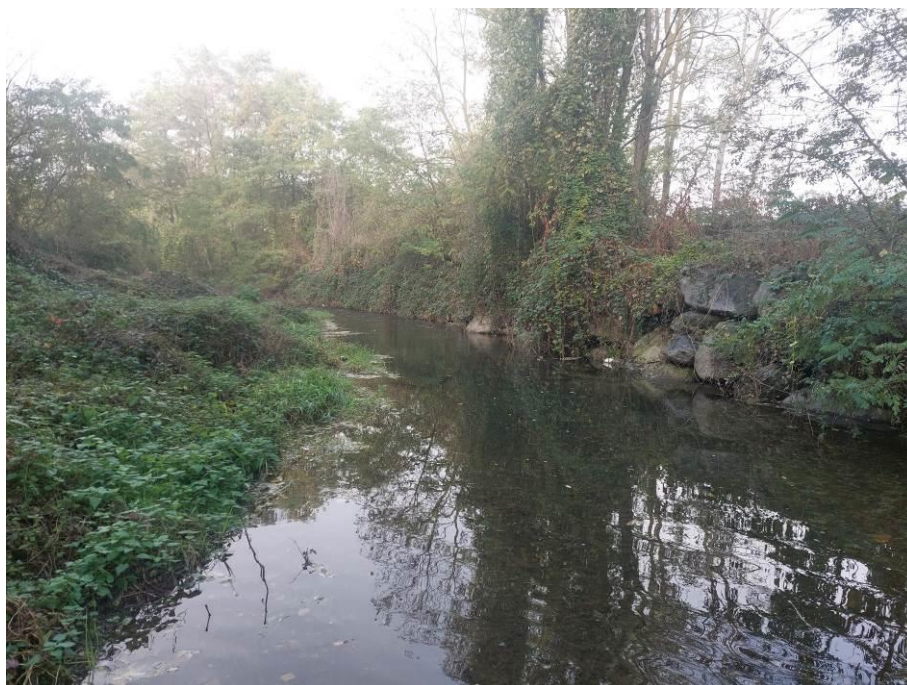
Foto 8 – Vista da valle delle scogliere oggetto di interventi di sottofondazione e alveo oggetto di riprofilatura e rimozione dell'isola di deposito in destra
