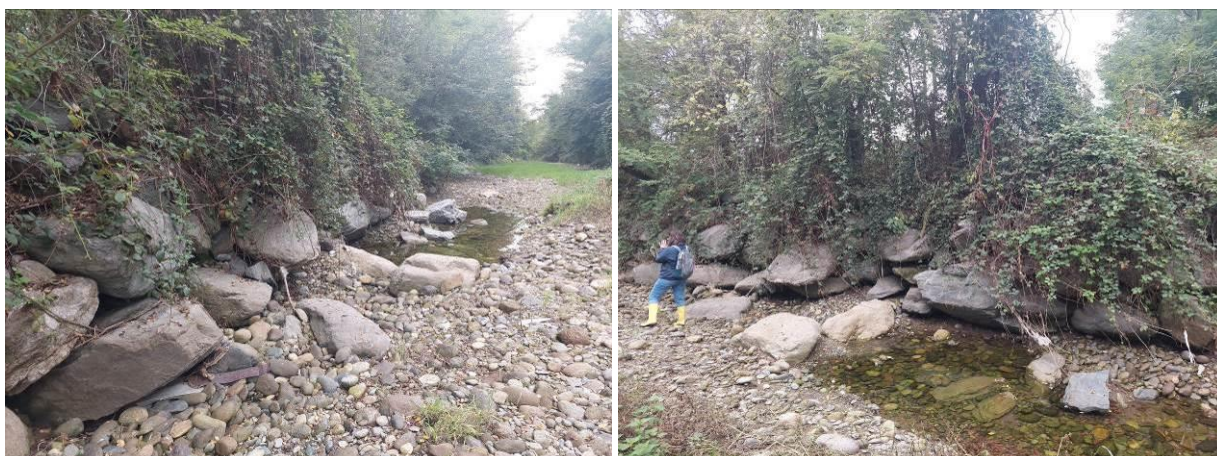
Figura 10 – Erosione al piede delle scogliere presenti in sinistra idrografica circa 100 m a valle della soglia
