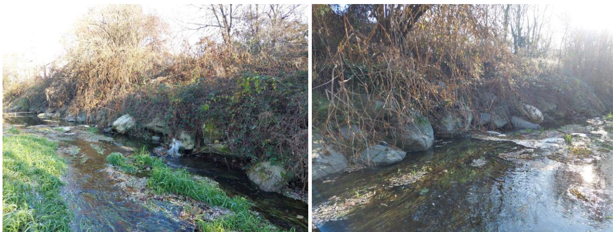
Figura 14 – Stato dei luoghi a ridosso degli stabilimenti Sparco e Sacrima. Scogliere in sinistra idrografica a monte degli stabilimenti che necessitano di interventi di protezione e sottofondazione del piede
